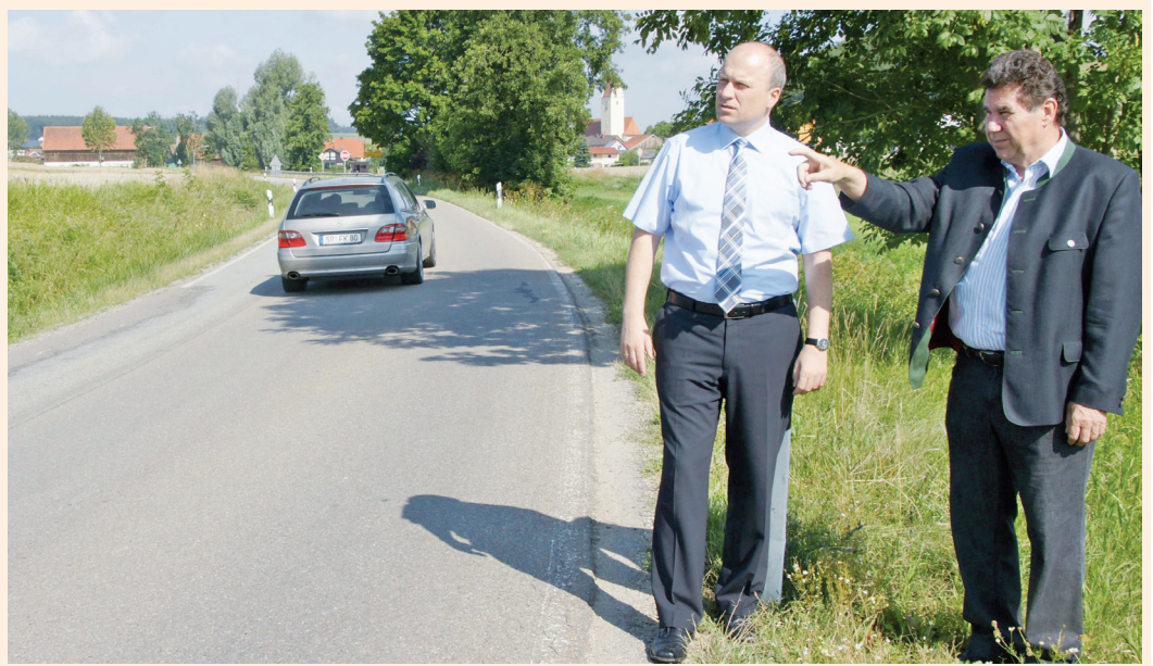
Die schmale Kreisstraße zwischen Schierling und Unterlaichling wird neu gebaut und erhält einen separaten Geh- und Radweg, was Bürgermeister Christian Kiendl und stellvertretenden Landrat Otto Gascher entscheidend gefördert haben
