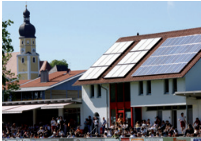
Auch auf dem Dach des Schierlinger TV-Vereinsheim mit Jugendtreff wird Strom erzeugt und das Wasser mit Sonnenenergie aufgeheizt
