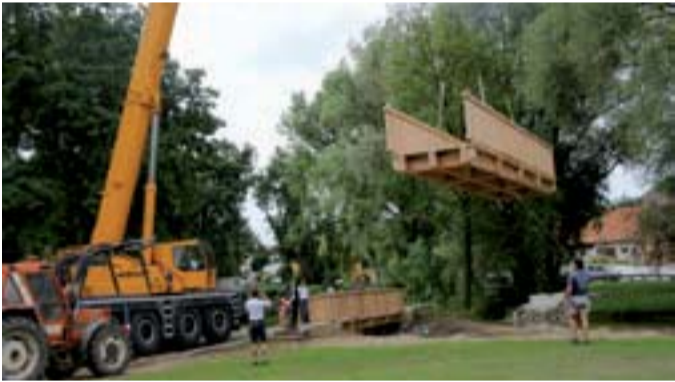
Mit einem großen Autokran wurden im Juni 2008 die neuen Holzbrücken des „Hohen Stegs“ im Rahmen der ökologischen Umgestaltung der Großen Laber eingesetzt
