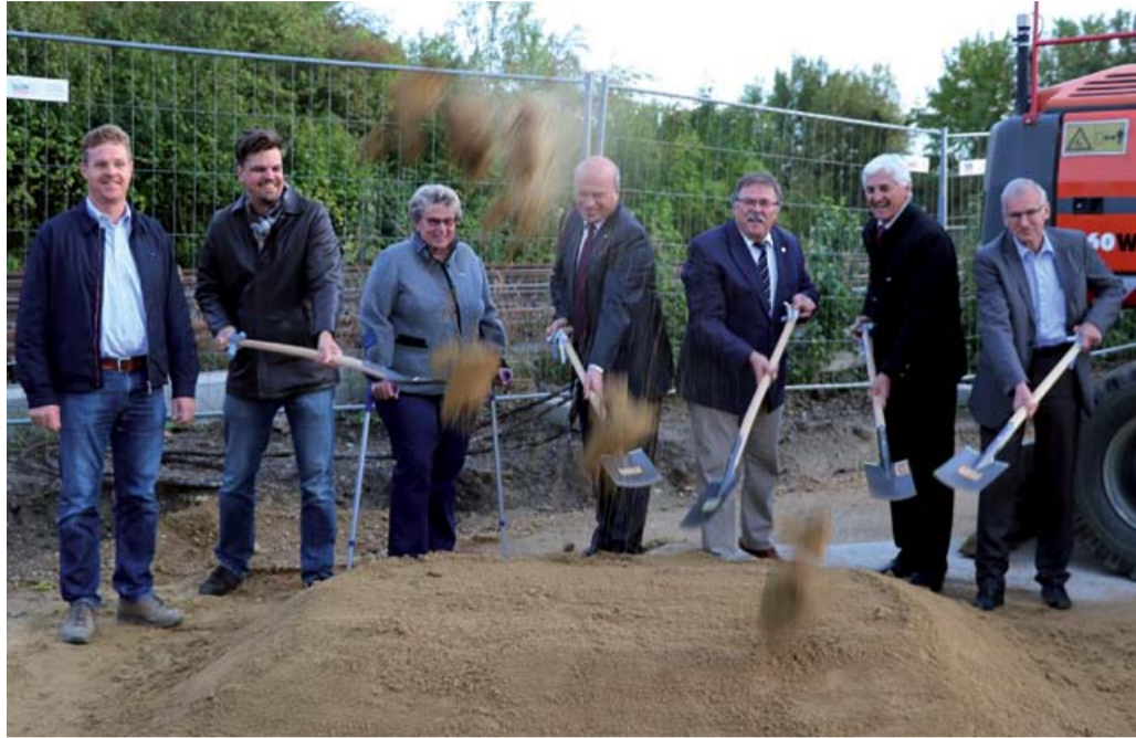
Den Spatenstich für die Erweiterung der P+R-Anlage am Bahnhof Eggmühl machten, von links, Thomas Schweiger-Beck von Fahrner Bau, Ingenieur Martin Dietl, zweite Bürgermeisterin Maria Feigl, Bürgermeister Christian Kiendl, stellvertretender Landrat Willi Hogger, dritter Bürgermeister Anton Blabl und Wolfgang Treppesch von der Eisenbahninitiative
