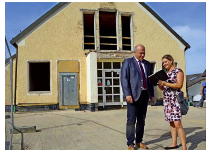
Das ehemalige Sparkassengebäude Eggmühl wird zu einer modernen und energieeffizienten Kindertagesstätte umgebaut und der Geldautomat bleibt für die Kunden erhalten
