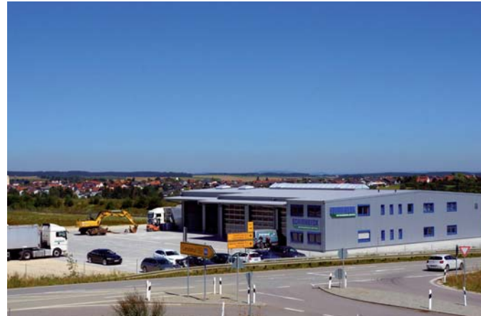
Im Gewerbegebiet „Am Birlbaum“ entstand mit LKW- und Nutzfahrzeuge-Service eine ganz neue Betriebsstätte
