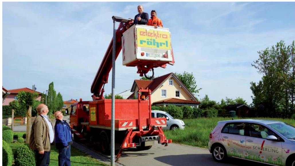
Schierlings Bürgermeister Christian Kiendl machte sich an Ort und Stelle – in luftiger Höhe – ein Bild von der Umstellung der Straßenbeleuchtung auf stromsparende LED-Leuchten
