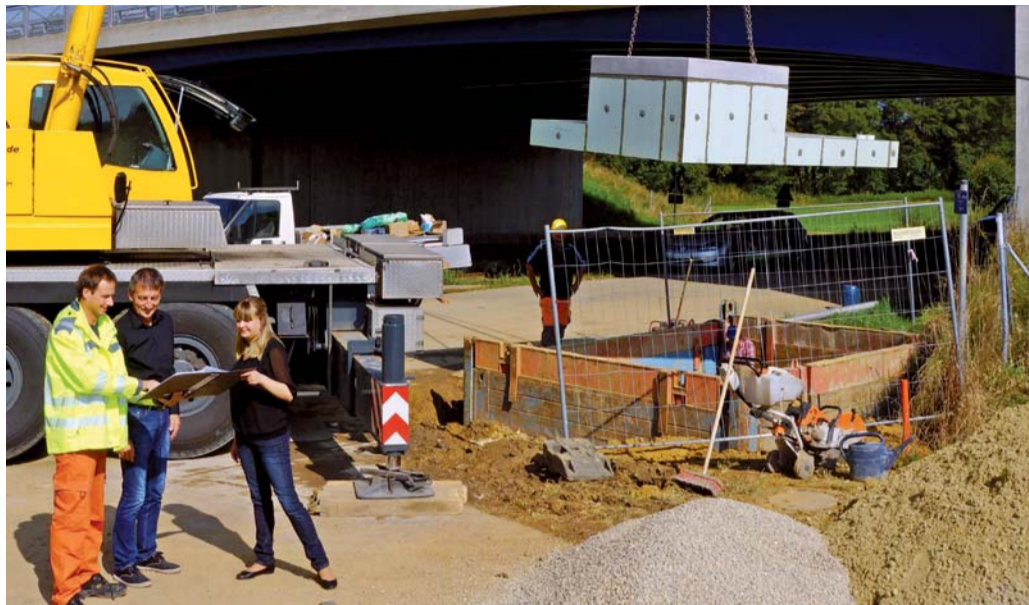
Unmittelbar an der Brücke der B 15 neu bei der Obermühle sind weitere Vorbereitungen für einen Notverbund zur Sicherung der Wasserversorgung getroffen worden
