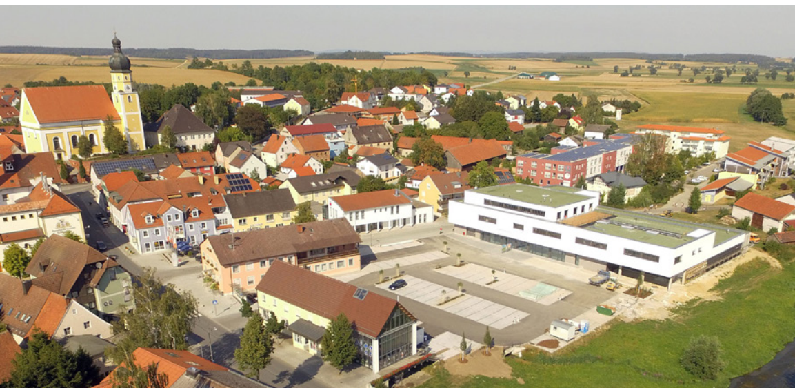
Wo heute das neue Geschäfts- und Bürgerhaus steht, war von 1978 bis 2014 das Feuerwehrgerätehaus.
