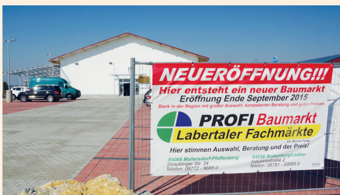
Bis zum 24. September sind nicht nur die Parkplätze startklar, sondern insgesamt 1.700 Quadratmeter Verkaufsfläche im und am Gebäude
