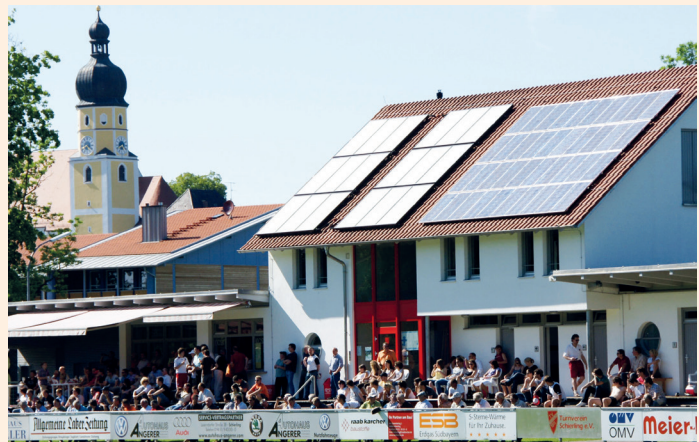
Auf dem Dach des TV-Vereinsheims wird Wärme und Strom erzeugt
